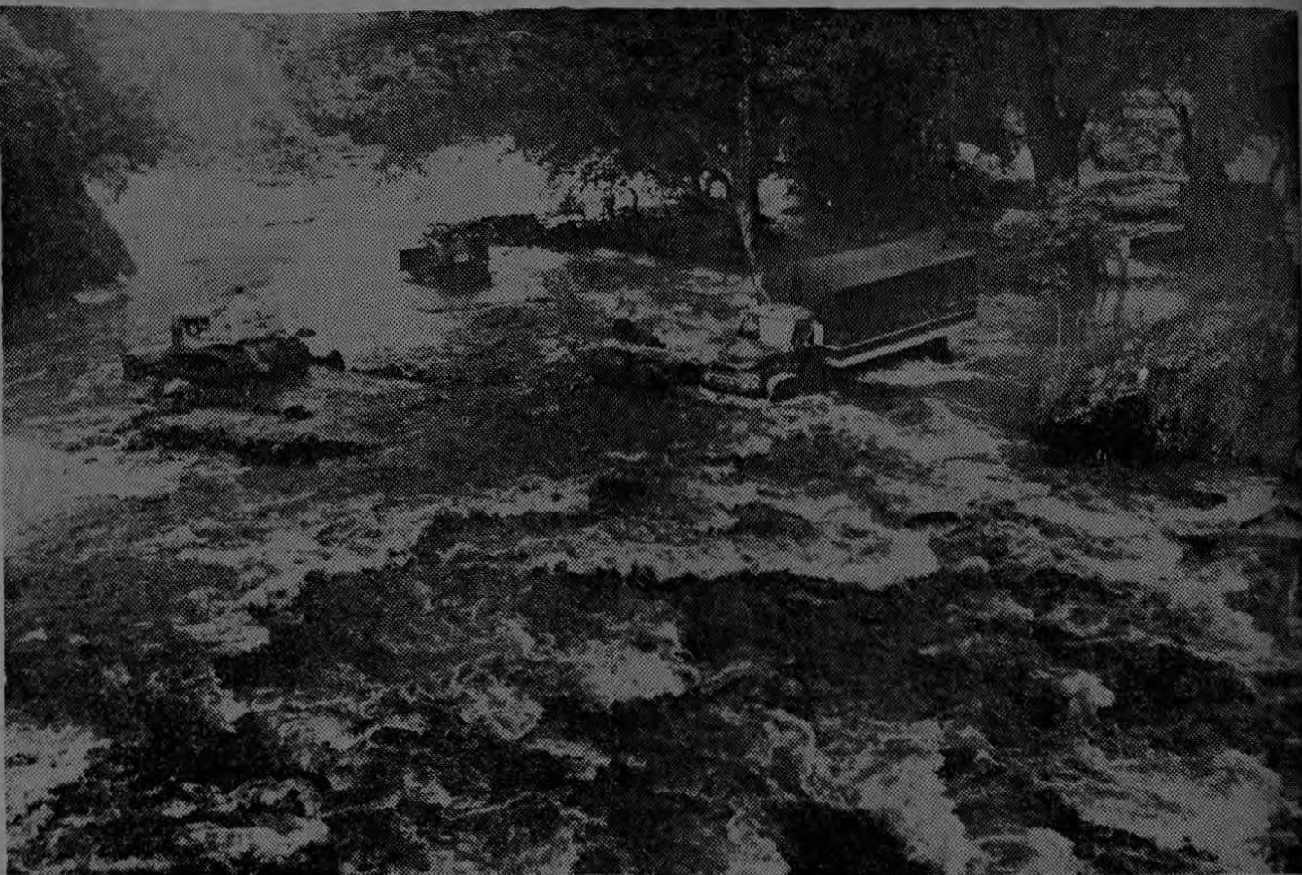
DESTROZOS EN INTERAMERICANA DEL NORTE. — En la gráfica pueden observarse dos tractores ayudando a un vehículo de carga a pasar el Río Ciruelas, debido a que el relleno entre los bastiones del puente y la carretera fue arrasado por aguas desbordadas, imposibilitando el paso por esa estructura.
